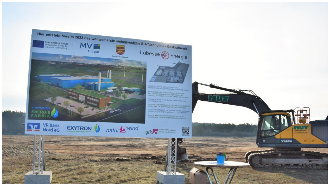
Die Bagger rollen in Lübesse – die erste emissionsfreie Energiefabrik entsteht in Mecklenburg-Vorpommern © exytron
