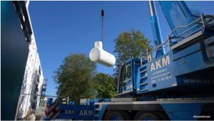
Einsetzen der Tanks im September 2018
