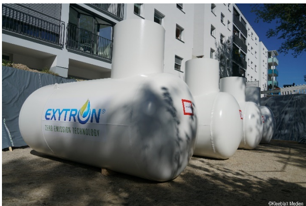
Installation der Tankanlage in Augsburg im September 2018
