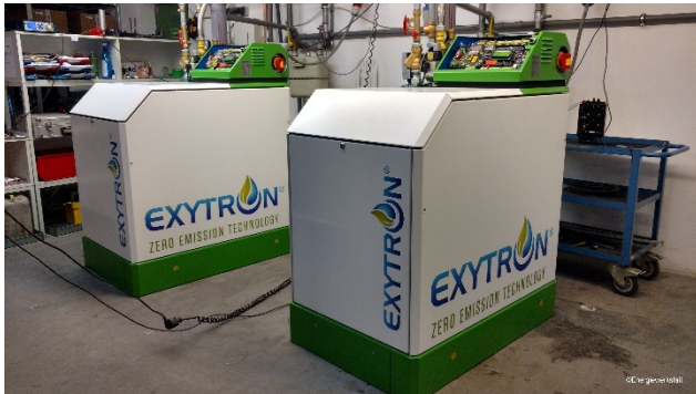
Installation der BHKW made by Energiewerkstatt am BernsteinSee im Dezember 2018
