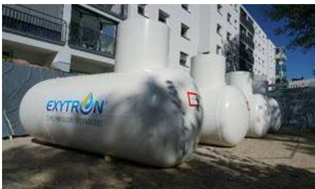
Installation der Tankanlage in Augsburg im September 2018
